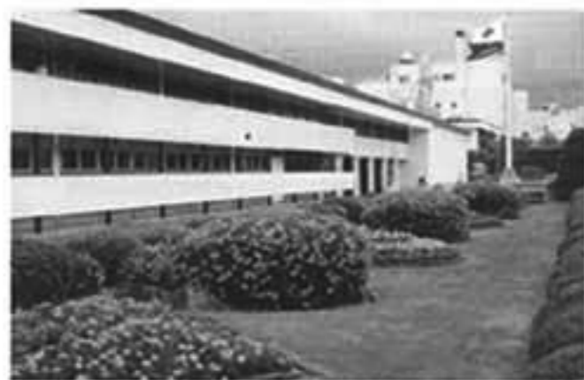
写真10 工場棟周囲緑地
